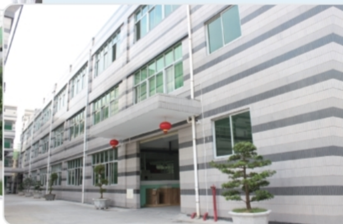
廠區 2/The factory
